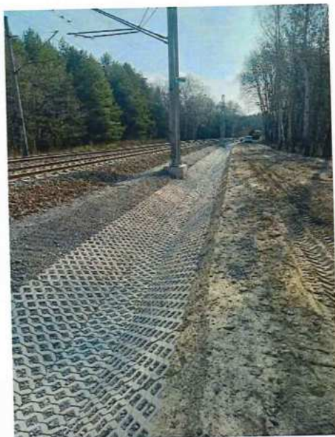
UČS 10, Zriadenie spevnených priekop a úprava svahov
