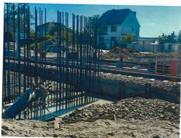
UČS 11, Betonáž bočných stien, podjazd Brodské
