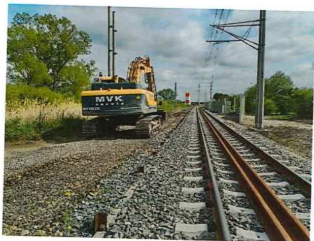
UČS 11, Odťaženie koľajového kameňa
