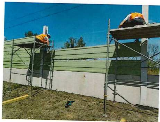
UČS 10, 11, Vkladanie výplňových panelov PHS
