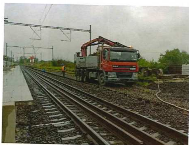
UČS 11, Odvoz demont. koľají a podvalov
