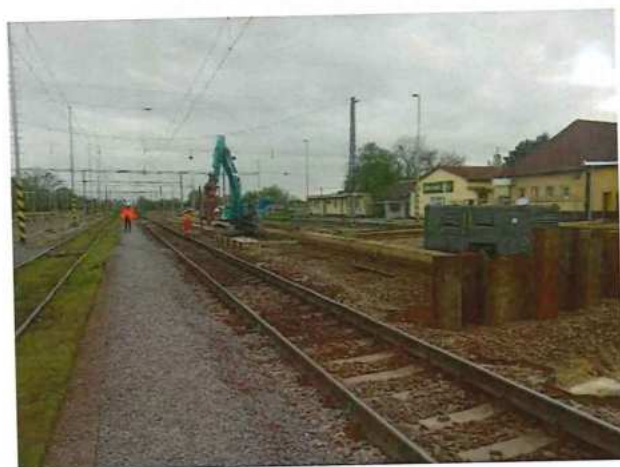
UČS 02, Realizácia štetovnic a HEB profilov v žst Zohor
